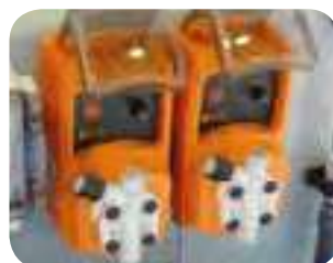
Pompe dosatrici per additivi di pre-trattamento
