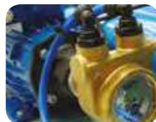
Gruppo di pressurizzazione con pompa a palette.
